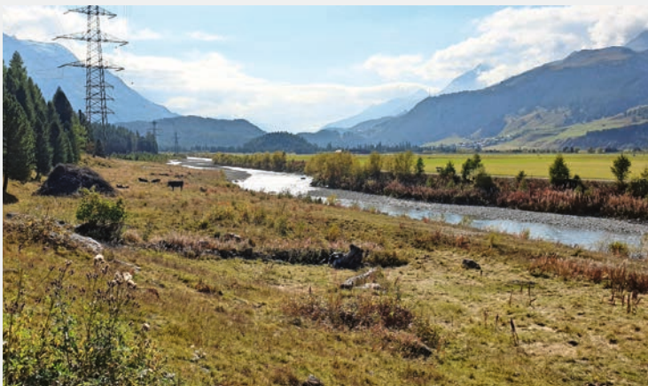
Fig. 4 Neue Führung des Flaz entlang des Hangfusses Muottas Muragl.
