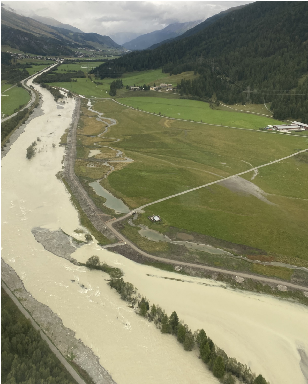
Der Inn, erstmals in seiner gesamten Breite. Im oberen Bildteil verengt er sich wieder in die ursprüngliche Breite zwischen den alten Dämmen (Foto: A. Gloor, 30.8.20)
