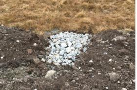
Bereits ist der grösste Teil des neuen Radweges mit einem feinkörnigen Belag fertiggestellt (links). Die zahlreichen kleinen Wasserläufe finden in diesen Steinhaufen eine Unterführung und gelangen so in den Bach auf der anderen Seite des Radweges (rechts).
