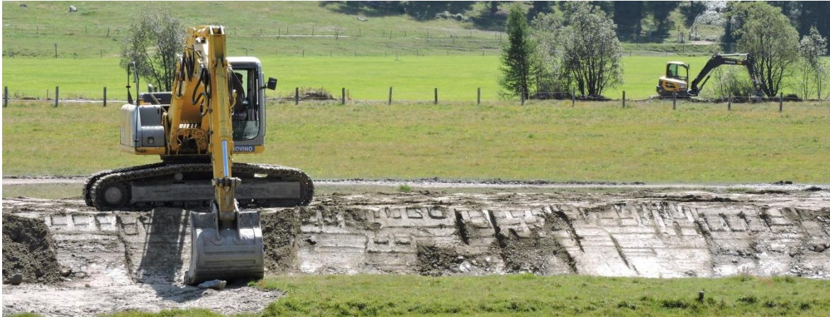
Der Bagger bringt das zugeführte Material in Form, um im nächsten Schritt den Damm darauf zu schütten.
