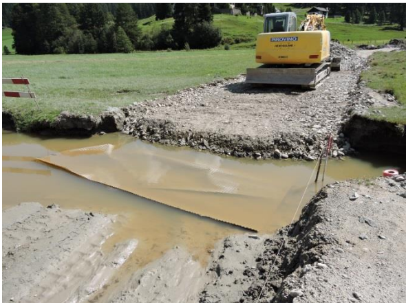
Die Bauarbeiten am neuen Veloweg machen Fortschritte. Geplant ist, dass er Mitte Herbst fertig wird. Im linken Bild ist das Vlies sichtbar, welches dem Strassenkörper die nötige Festigkeit gibt. Die Wasserlache, in der das Vlies liegt, bildet sich aus Grundwasser und zeigt, wie hoch hier der Grundwasserspiegel ist.
