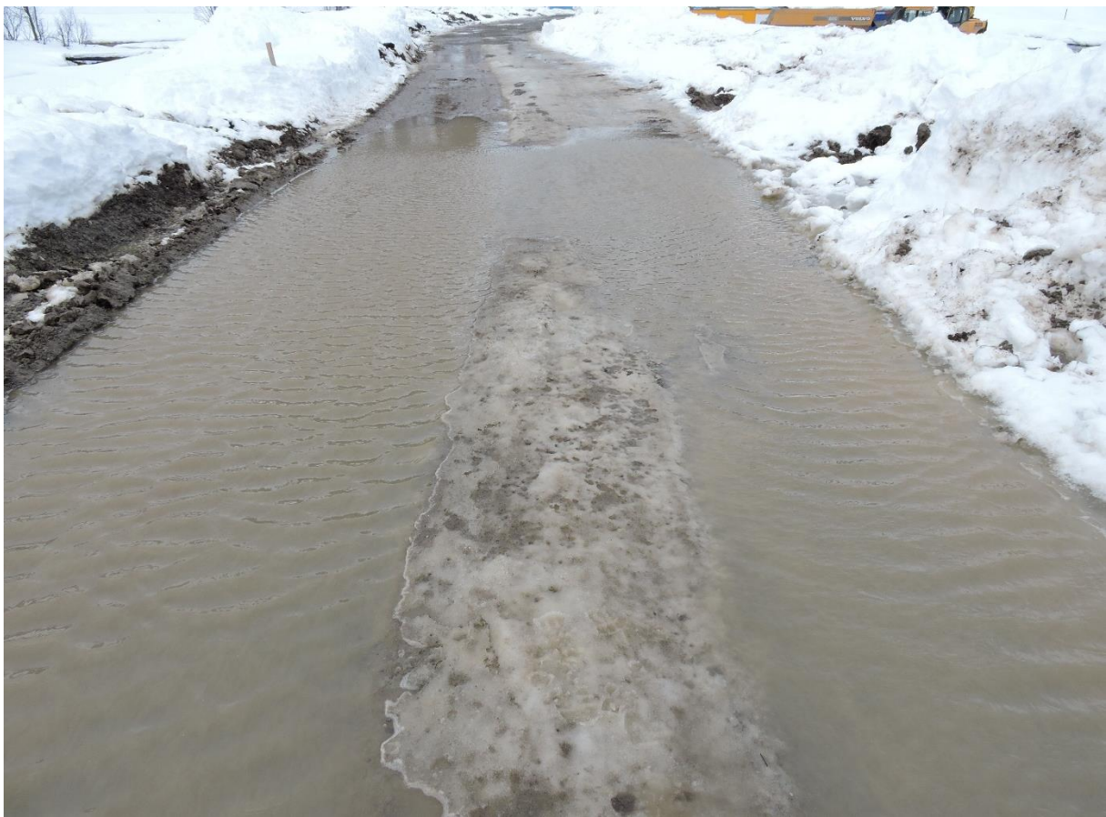
Zum Spazieren ist es nicht gerade einladend, aber schliesslich ist das hier auch kein Winterwanderweg, sondern eine Baustelle (24.11.19).
