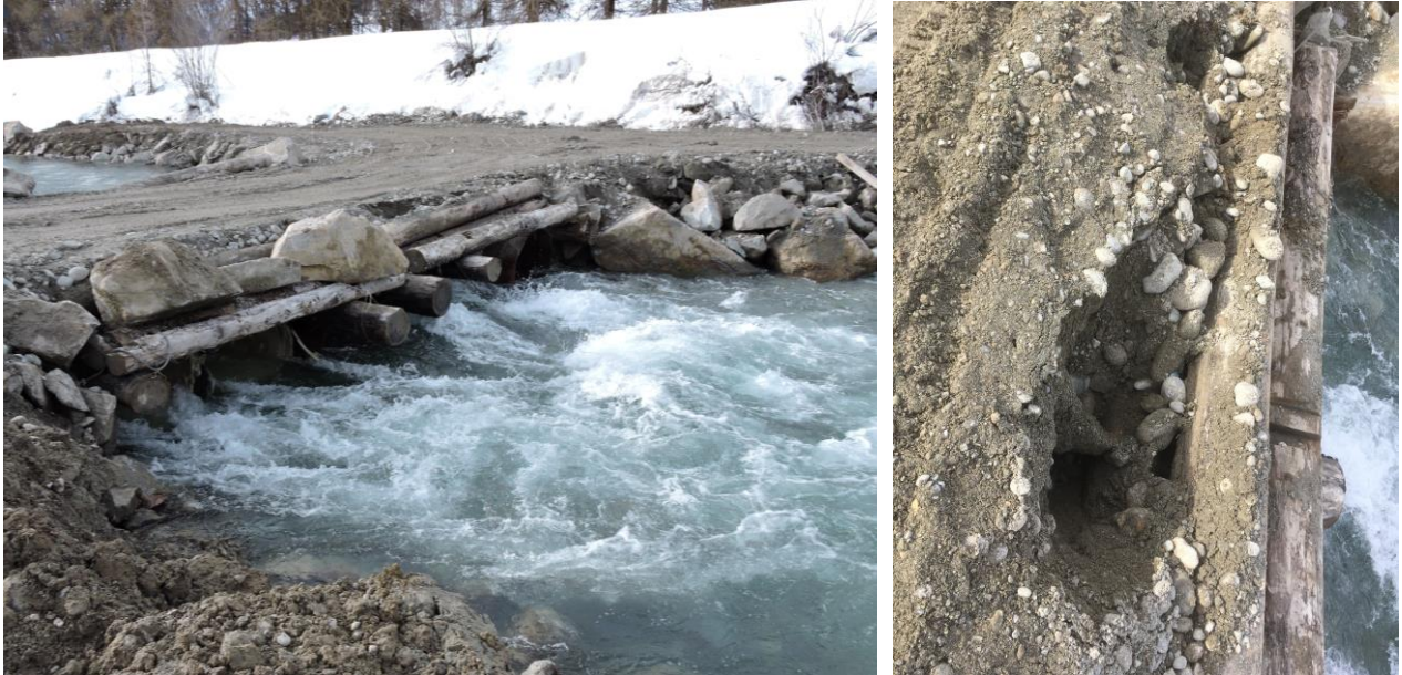
Die temporäre Brücke ist nur für Baumaschinen gedacht. Wie das rechte Bild zeigt, ist der Belag nicht für Fussgänger ausgelegt.
