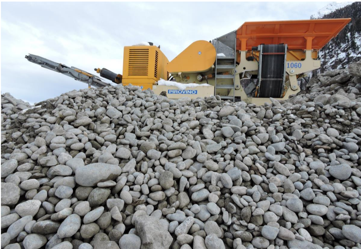
Hier kommt das Innenleben des alten Damms zum Vorschein: Die Sortiermaschine erlaubt eine effiziente Weiterverwendung des wertvollen Materials.
