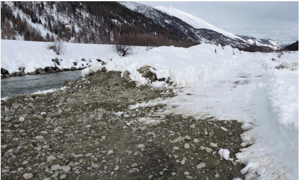
Die Schneegrenze verrät die Baufront: Unter dem Schnee verbirgt sich noch ein Wall, der den freien Blick auf den Inn verhindert. Solange der Boden noch nicht gefroren ist, verschiebt sich diese Baufront täglich weiter flussabwärts (24.11.19)
