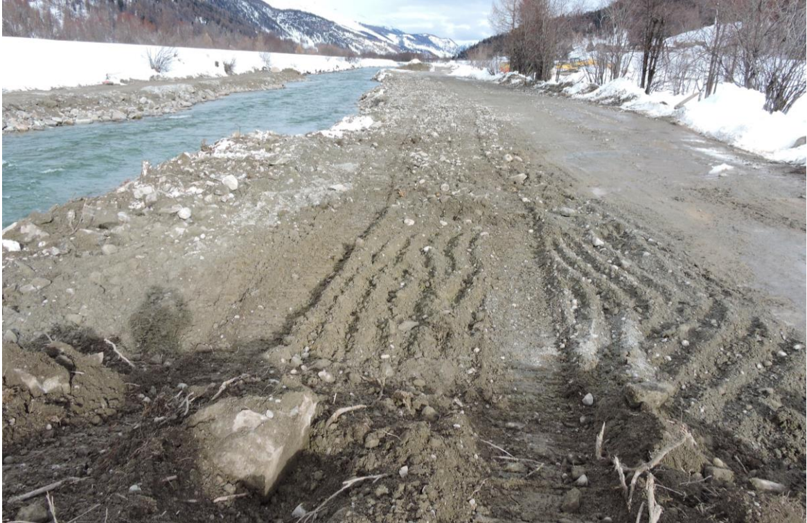
Hier ist der Damm bis auf die Baupiste abgetragen. (24.11.19).
