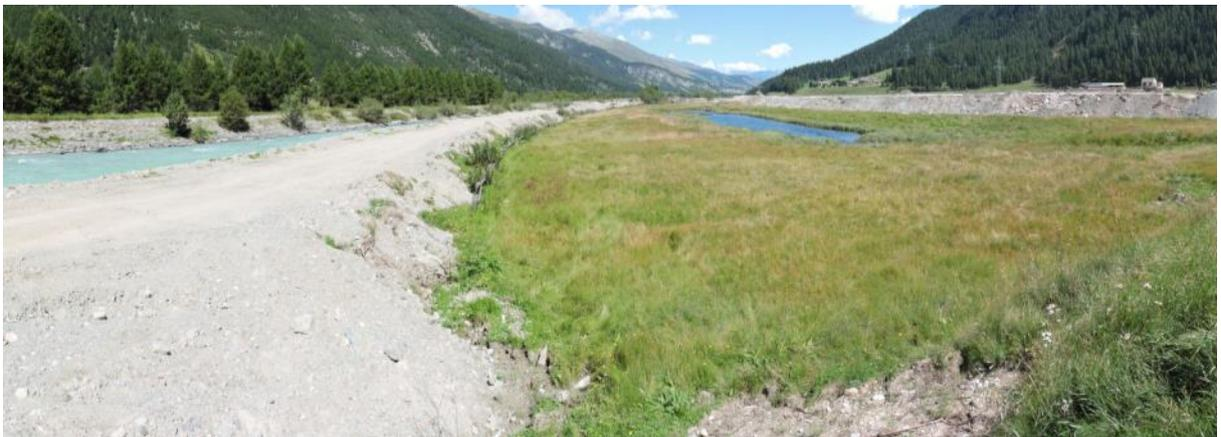
*Oben: Ende Mai 2019, der alte Damm ist noch unversehrt, beim neuen Damm ist der Erosionsschutz sichtbar, die Vorschüttung fehlt noch. Unten: Ende August 2019, der alte Damm ist nur noch halb so hoch und die Vorschüttung am neuen Damm verbirgt den Erosionsschutz.*
