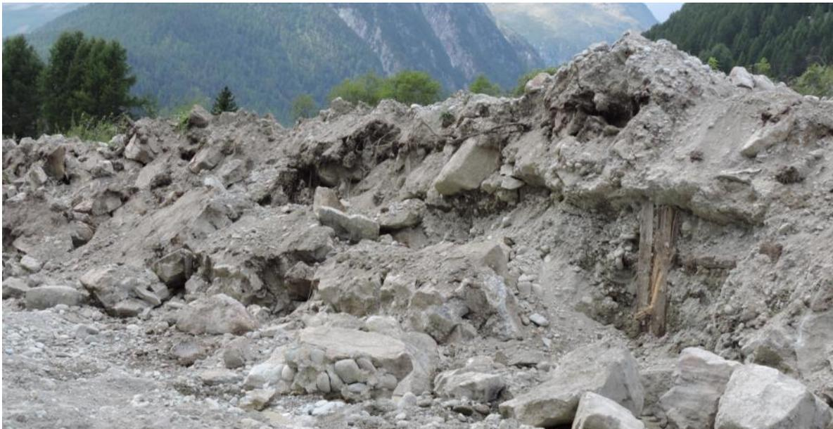
*Die Überreste des alten Damms erlauben einen Blick in seinen Aufbau, rechts im Bild sind Holzbretter erkennbar (31.8.19).*
