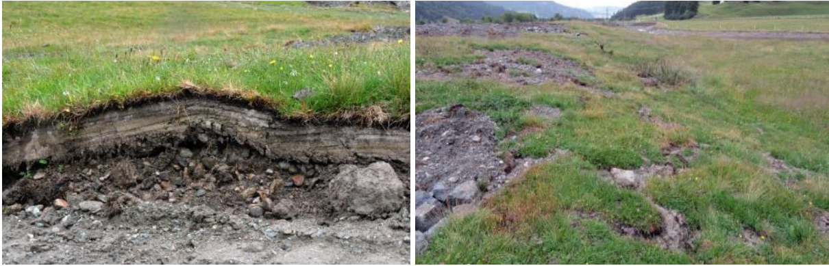
Das Versetzen von ganzen Rasenziegeln bringt eine fast sofortige Begrünung und im Nu sieht die flache Dammböschung in Richtung Weideland aus, als wären die Bauarbeiten hier schon lange fertig.
