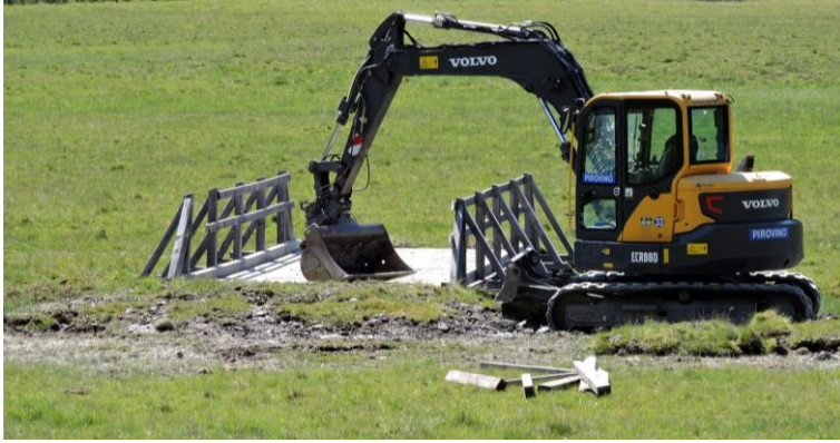
Noch Mitte Juli steht die Holzbrücke verloren und sinnlos in der grünen Wiese. Doch die Anwesenheit des Baggers lässt bereits erahnen, dass sich hier bald etwas verändern wird (Foto: 14.7.19).
