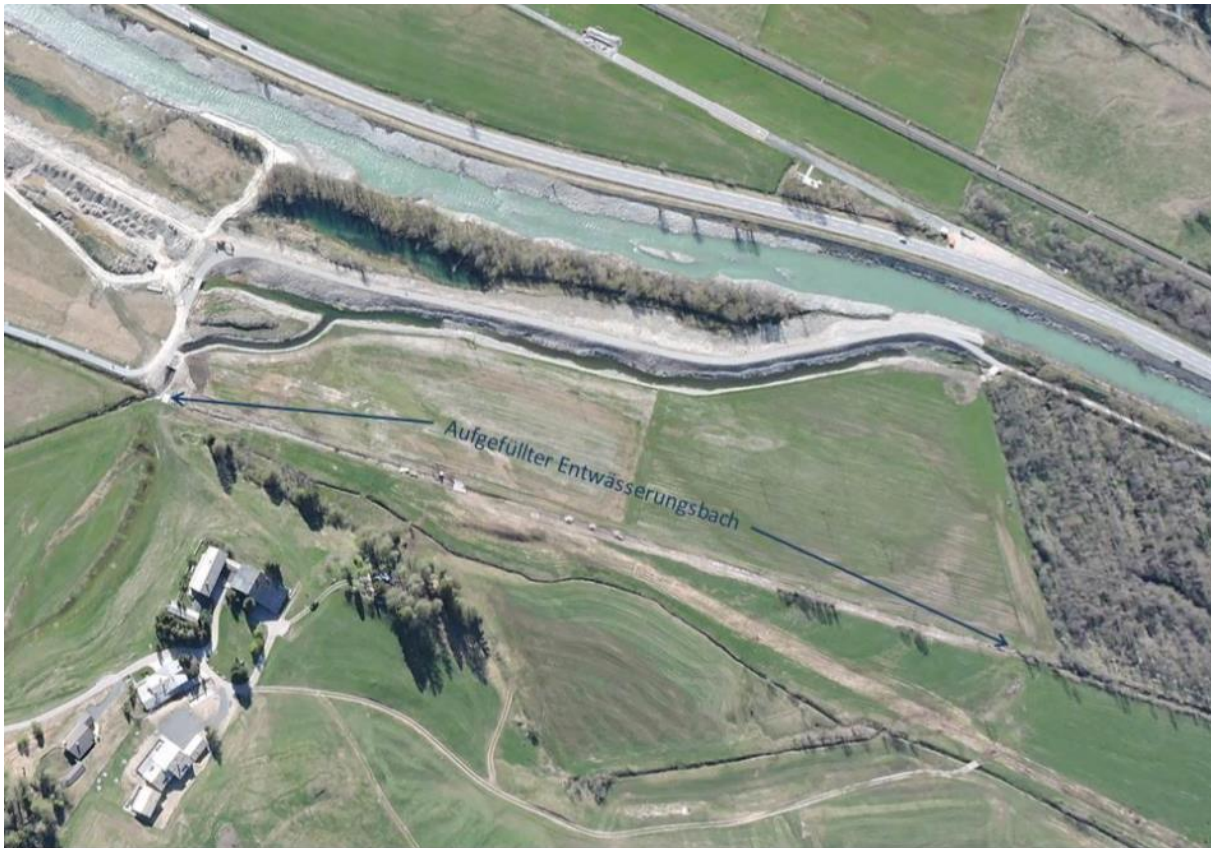
Der aufgefüllte Entwässerungsbach unterhalb Champesch ist mit blauen Pfeilen markiert. Er wird im Verlauf des Sommers ganz aus dem Landschaftsbild verschwinden (Foto: 1.6.19).
