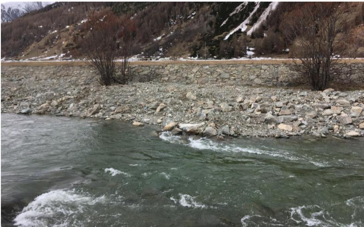
*Das Foto zeigt den alten, linksseitigen Inndamm, der bestehen bleibt, aber eine Vorschüttung bekommt. Bis auf die Höhe der Weiden ist die Vorschüttung, bestehend aus Material des abgebrochenen Damms, gut sichtbar.*
