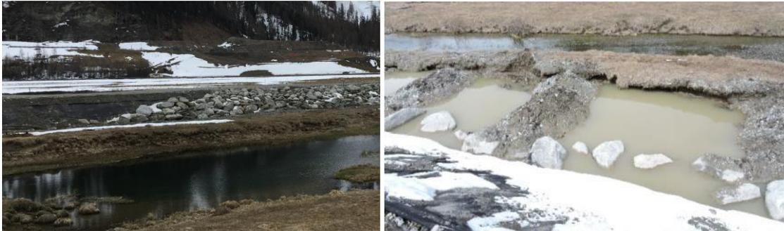
*Links: Hier wird gerade der Erosionsschutz in Form grober Gesteinsblöcke angebracht. Links im Bild ist noch das schwarze Geotextil sichtbar, das sich darunter befindet. Rechts: Hier muss noch der Erosionsschutz am Dammfuss eingebaut werden.*
