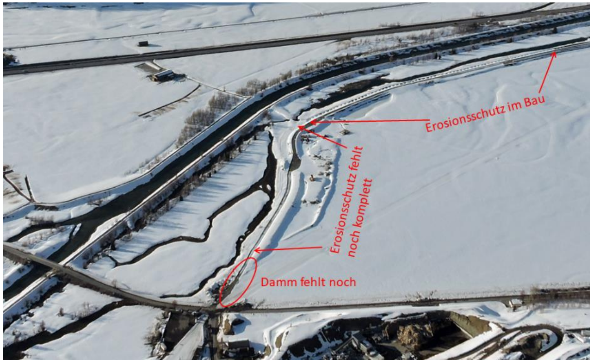
Ist der Schnee geschmolzen, der Boden auf der Baustelle getrocknet und der Wasserstand im Inn zu hoch für die Rückbauarbeiten am alten Damm, konzentrieren sich die Arbeiten wieder auf den neuen Damm im oberen Teil des Perimeters. Die Abbildung zeigt, wo diesen Sommer welche Arbeiten anstehen (Foto: 29. März 2019).
