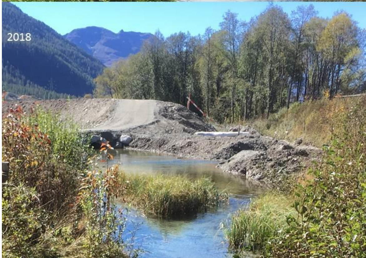
Zwischen diesen beiden Aufnahmen hat sich der neue Damm ins Bild geschoben, ganz rechts ist noch der alte Damm erkennbar, den es mittlerweile an dieser Stelle nicht mehr gibt. Die Fotos entstanden unmittelbar bei der Gemeindegrenze zu La Punt – Chamues-ch.
