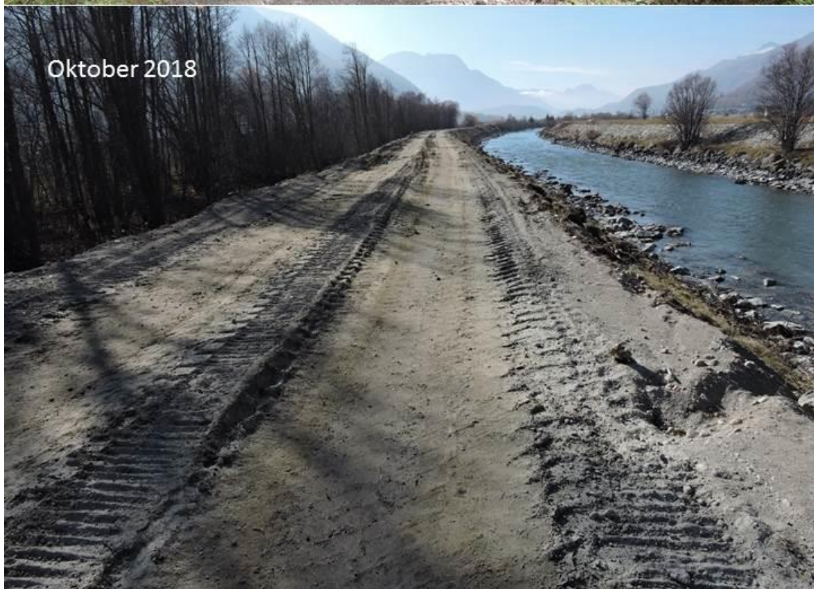
Der alte Damm ist hier bereits ein Stück weit abgetragen und somit Geschichte. Der Blick öffnet sich auf den Inn.
