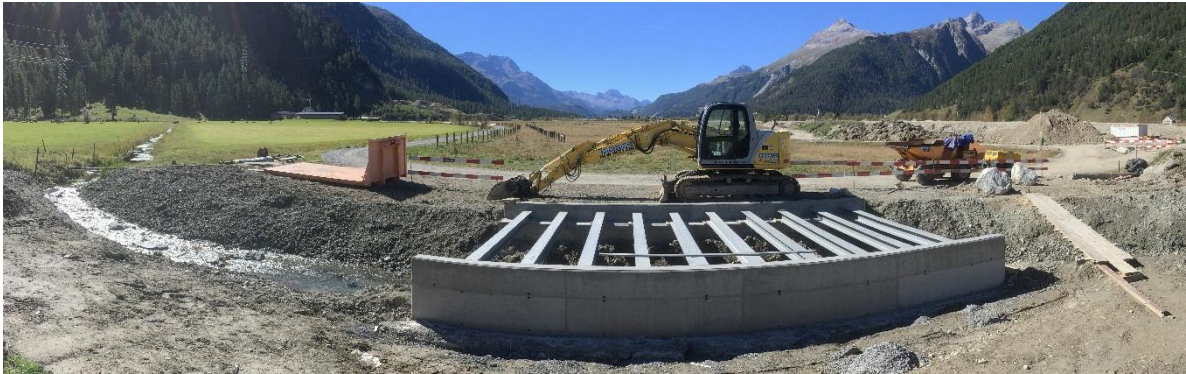
Oben: Diese neue Holzbrücke führt die Velofahrer über das Stillgewässer auf den Damm. Unten: Noch ist die Langlaufbrücke nicht begehbar, aber es liegt ja auch noch kein Schnee...
