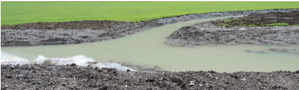
Die neuen Stillgewässer ausserhalb des neuen Damms Ende August 2018.
