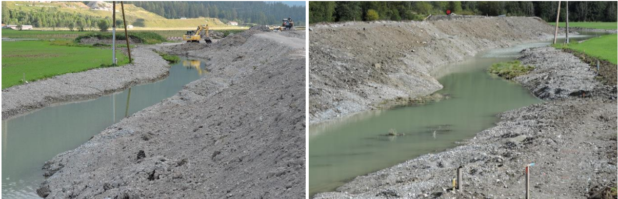
Das neu angelegte Stillgewässer im untersten Bereich der Baustelle, zwischen dem unteren Installationsplatz und der Gemeindegrenze zu La Punt – Chamuesch.
