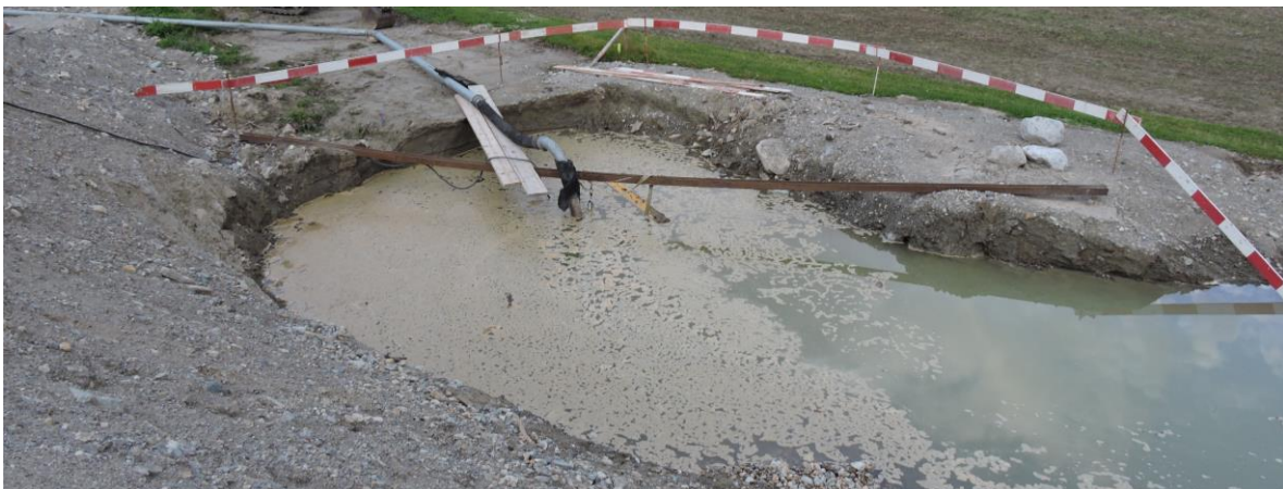
Eine Pumpe sorgt dafür, dass der Wasserstand im neuen Stillgewässer genug tief ist für die Bauarbeiten. Das Bild entstand an einem Sonntag, als die Pumpe ausgeschaltet und der Wasserstand entsprechend hoch war.
