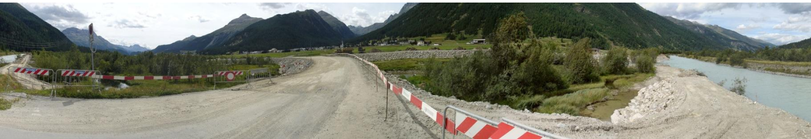
Aufnahme während Bauarbeiten am 13. Juli 2012
