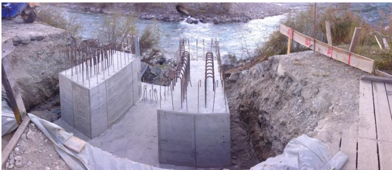
Die Brücke weist eine Spannweite von ca. 31m auf. Die Brückenlager bestehen aus jeweils ca. 24m 2 Ortbeton.
